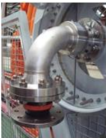
图示：配备不锈钢旋转接头的软管系统
